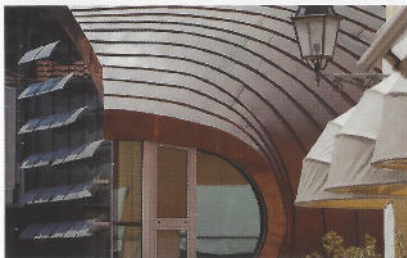
85 "Il Guscio", recupero edificio ex Bagni
