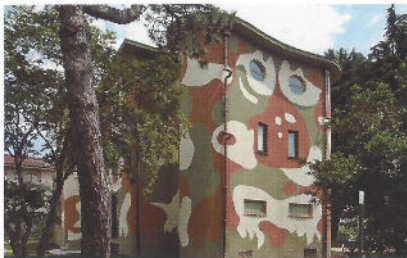
82 "Casa Mimetica", ristrutturazione ed ampliamento di abitazione unifamiliare con realizzazione di 12 monolocali
